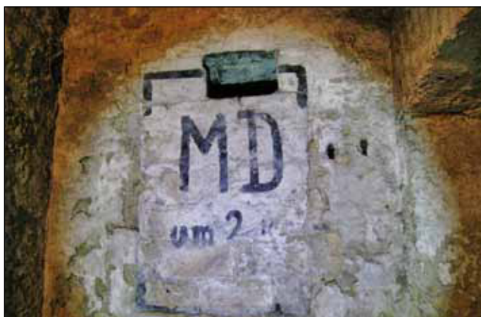
MD (= Mauerdurchbruch) im Haus Nr. 12 am Döblinger Gürtel
